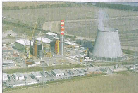
Central Termoelectrica do Ribatejo em Outubro 2003
