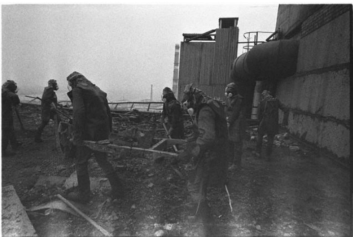
Figura 8 - Liquidatários (ou 'bio-robôs' como assim ficaram sendo conhecidos) limpando o teto do reator. No início, as autoridades tentaram limpar os restos radioativos usando robôs japoneses e russos, mas eles não funcionaram adequadamente com a extrema radiação. Por isto, as autoridades decidiram utilizar seres humanos para o trabalho. Os soldados não podiam ficar geralmente mais de 40 segundos cada vez que subiam no teto do reator, tamanha era a radioatividade naquele local. Muitos já morreram ou sofrem de problemas de saúde graves. Observem as 'nuvens brancas' intercaladas na foto, resultado da radiação no local.
